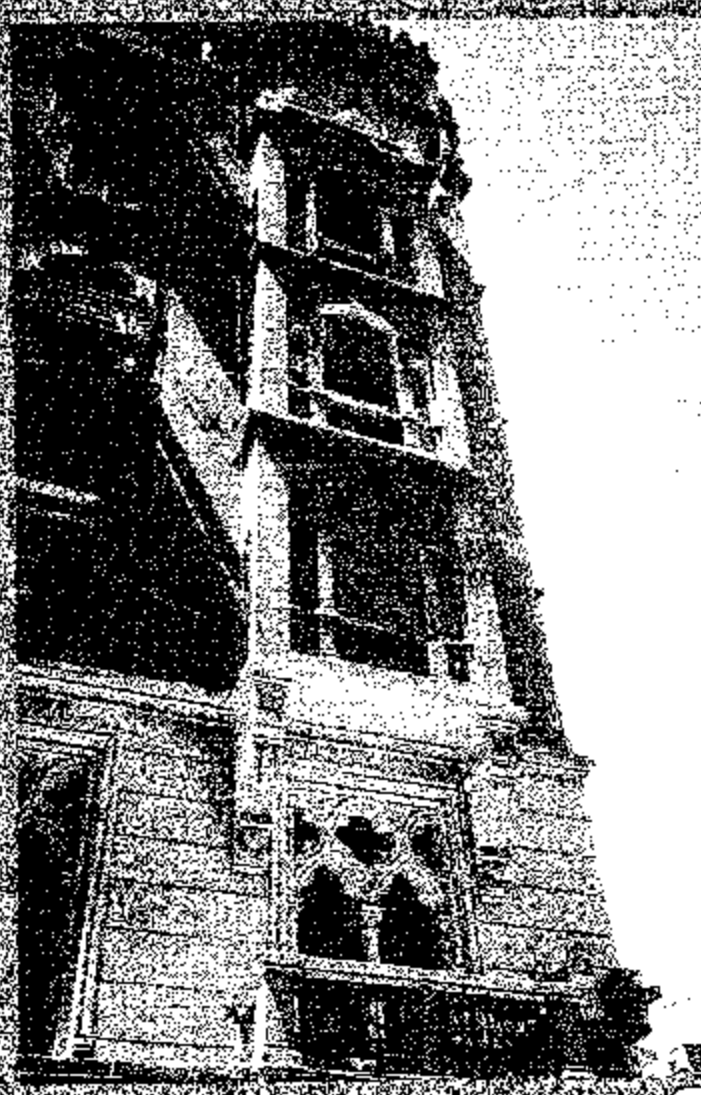
16 Hoda Sharawy St. شارع هدى شعراوي Detail of Building Corner تفصيلة توضح ركن المبنى الذي تم سد بعض فتحات الشبائيك فيه بالطوب.
